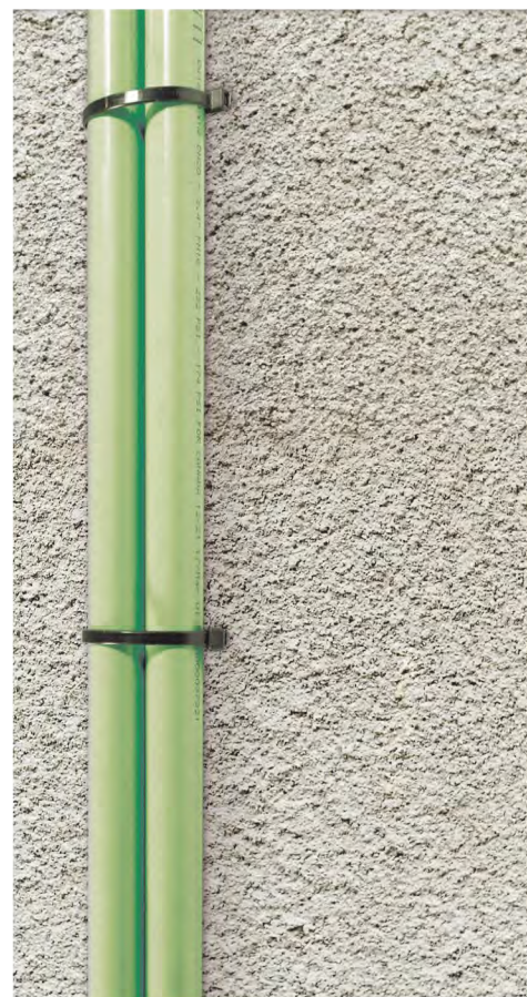
3. Introducir la brida al anclaje.
