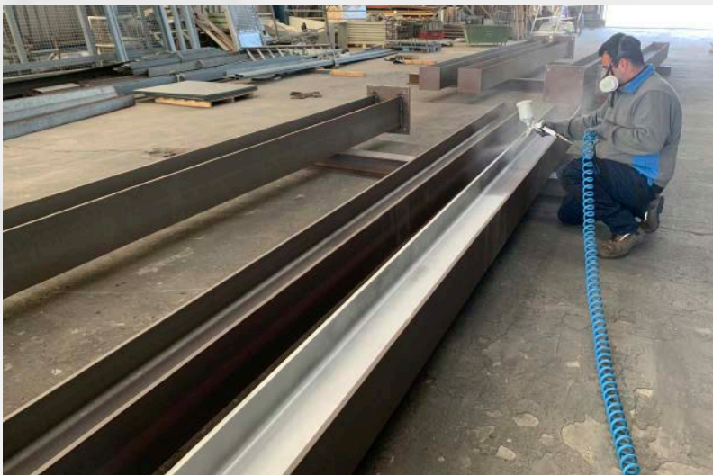
Ejemplo de aplicación de Tecnadis Multicoat Anticorrosión (Primer) sobre superficie ligeramente oxidada
