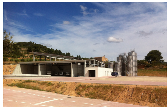
SOLERAS BODEGA DE CAVA TARRAGONA
