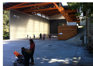
FRONTÓN DE PELOTA VASCA GIPUZKOA
