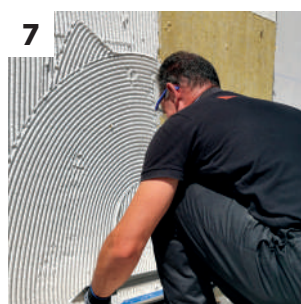
7 Aplicación de la superficie dentada con ISOVIT FIBRAFLEX
