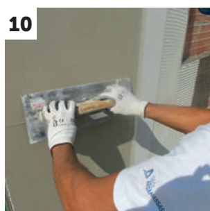
10 Aplicación de la primera capa de REABILITA CALAC
