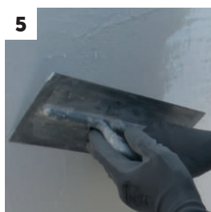
Primera aplicación de ISOVIT FIBRAFLEX
