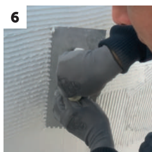
Aplicación de la superficie dentada
