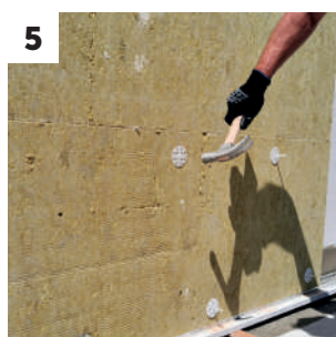
5 Colocación de ISOVIT Bucha - inserción
