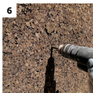
6 Realización de los orificios para colocar la fijación mecánica
