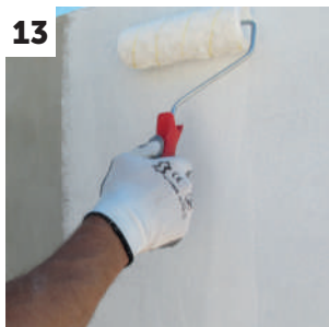
13 Aplicación de la imprimación ISOVIT AD 25
