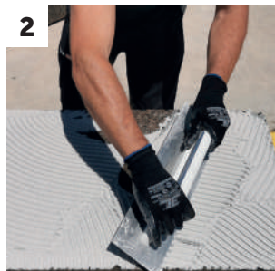
2 Colocación de ISOVIT E-CORK en la parte posterior de los paneles mediante el método de encolado continuo
