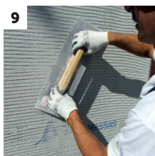
9 Segunda aplicación de ISOVIT E-CORK
