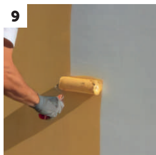
9 Aplicación de la imprimación ISOVIT AD 20
