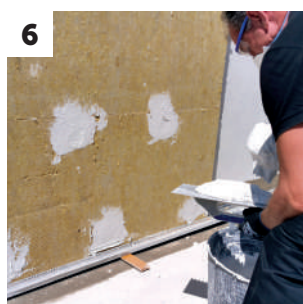
6 Primera aplicación de ISOVIT FIBRAFLEX
