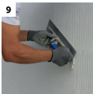
Segunda aplicación de ISOVIT FIBRAFLEX
