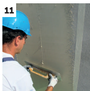
11 Acabado con una talocha de la superficie final de REABILITA CALAC
