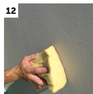
12 Esponjado de la superficie para obtener un acabado de arenado fino
