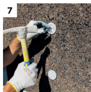
7 Colocación de ISOVIT Bucha
