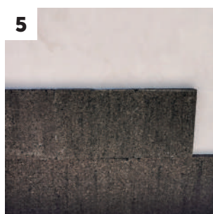
5 Colocación de las placas a contrapelo
