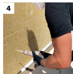
4 Colocación de ISOVIT Bucha - perforación
