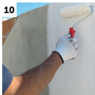
Aplicación de la imprimación ISOVIT AD 20
