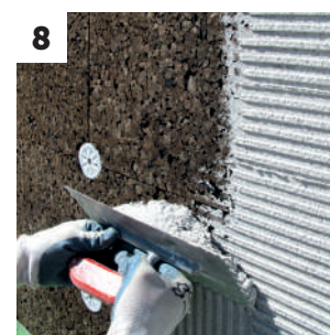
8 Primera aplicación de ISOVIT E-CORK
