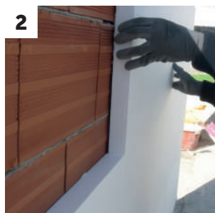
2 Colocación del panel sobre el soporte
