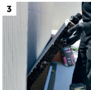
3 Colocación del panel sobre el revoco
