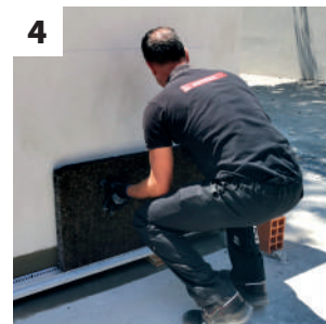
4 Encolado del panel aplicando presión
