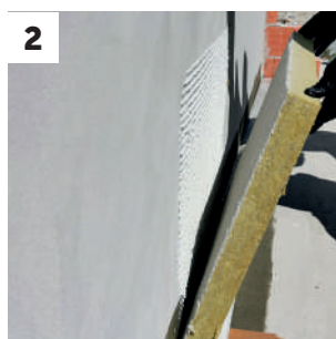
2 Colocación del ISOVIT panel KI sobre el revoco
