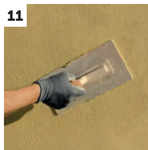
Aplicación del acabado acrílico ISOVIT REV
