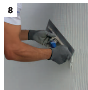
Segunda aplicación de ISOVIT FIBRAFLEX
