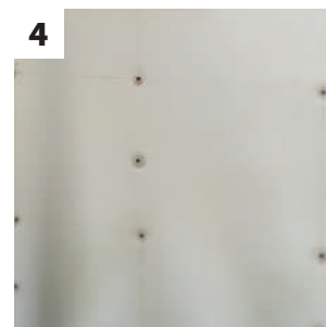
4 Colocación de ISOVIT Bucha
