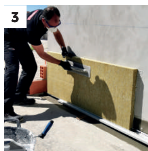
3 Encolado del ISOVIT panel KI ejerciendo presión
