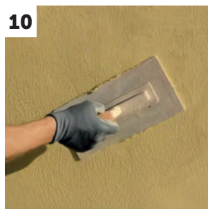
10 Aplicación del acabado acrílico ISOVIT REV
