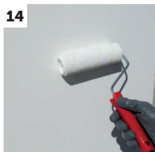
14 Aplicación de pintura de silicatos ISOVIT REV SP
